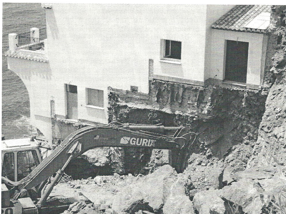
(Imagen del lateral de la vivienda, que ha sido excavado dejando al aire parte de la cimentación de la casa)
