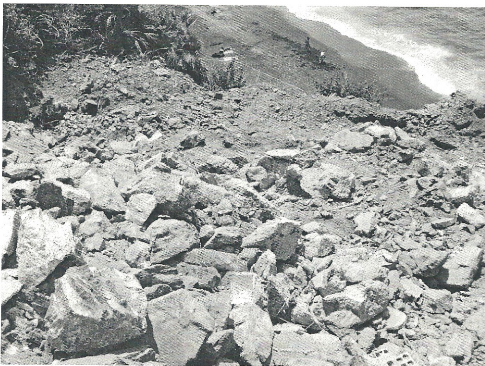
(Vista de rocas y restos de escombros resultado de la excavación del terreno y demolición de construcciones de la fachada oeste de la Casa Helios. Se observa la fondo la playa de "El Curumbico" y el gran desnivel que exige adoptar medidas de seguridad para evitar desprendimientos y caída de materiales)
